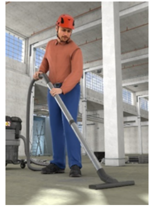
Bild 1: Baustellenreinigung mit Entstauber und Sauggarnitur [H.ZWEI.S Werbeagentur GmbH - BG BAU]
